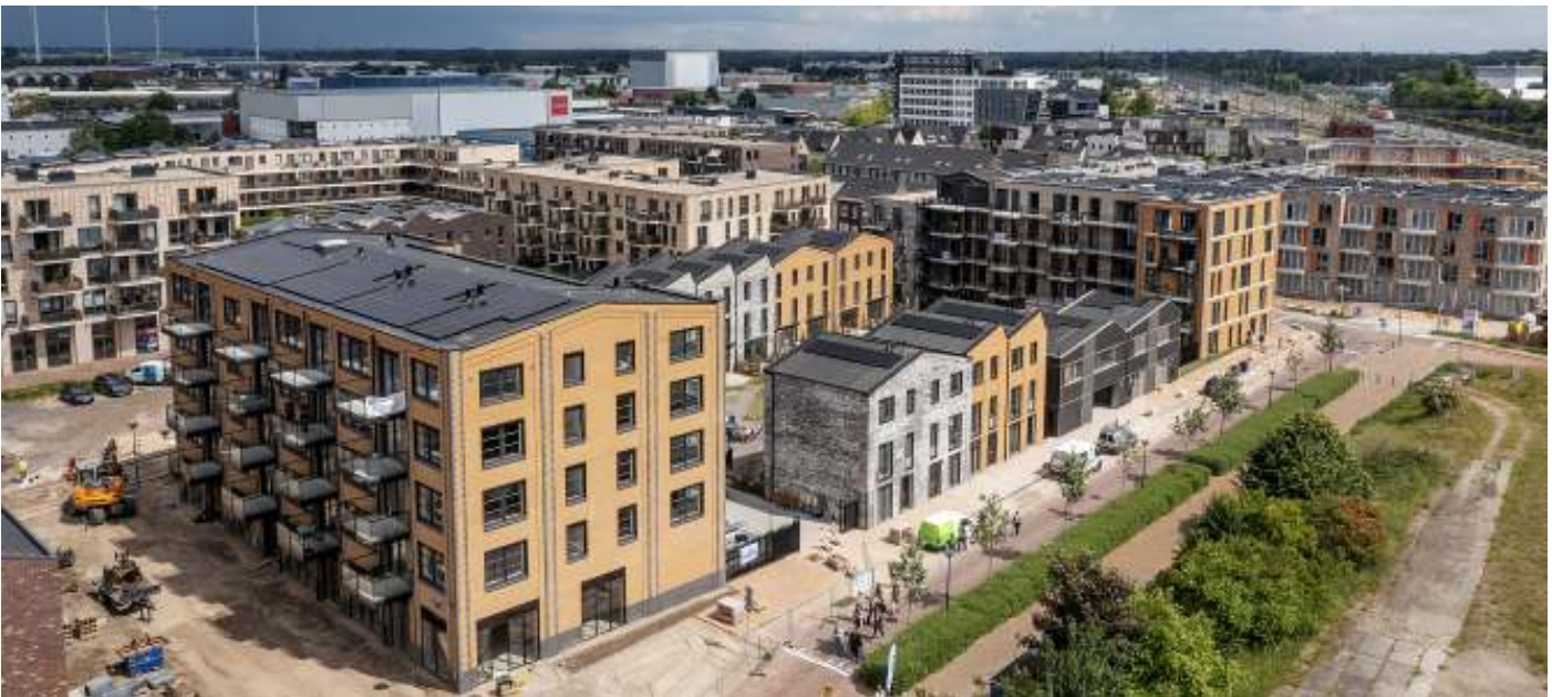
Het Hof van Zutphen in aanbouw
